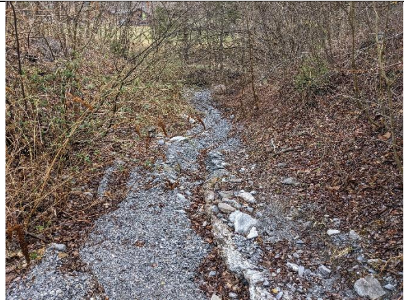
Vidameidabach , bei km 0.026 und Blick zur Tamina; Bereich Einmündung Lattläuibach, von links
