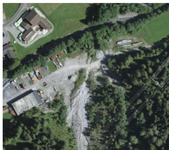
Gleicher Ausschnitt Kieswerkareal, Orthofoto, Lattläuibach mündet oberflächlich in Vidameidabach
