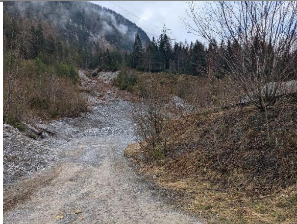
Lattläuibach , gegen Fliessrichtung, Verlauf durch Kieswerk-Areal
