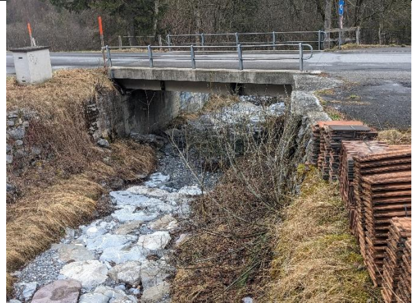
Bild 2: Chrüzbach, im Bereich km 0.150 und Blick zur Brücke Vättnerstrasse bei km 0.136 (QPC 6)
