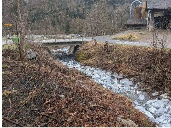
Bild 1: Chrüzbach, bei km 0.270 und Blick zur Brücke bei km 0.248 (QPC 2)
